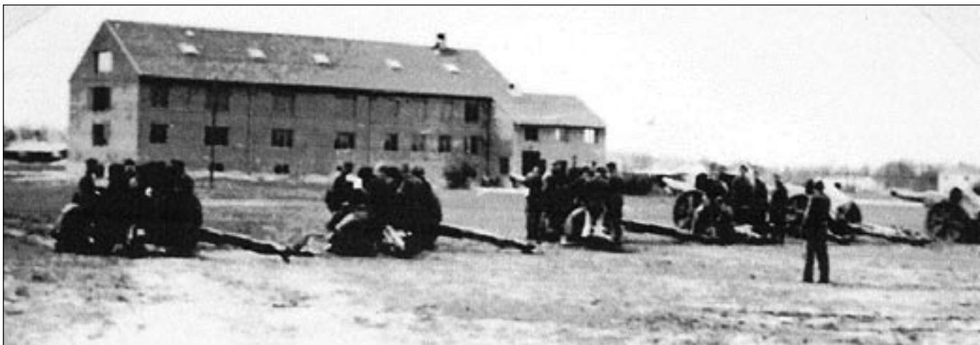
Kasern II under uppförande (enligt uppgift var den färdig oktober 1944)
