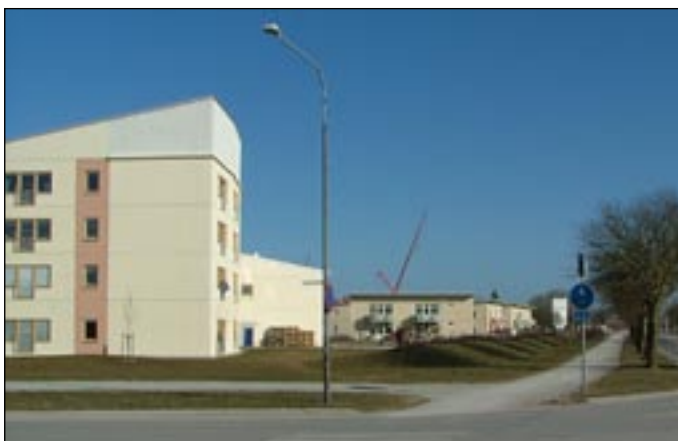
I den sydöstra delen dominerar i dag äldreboendet Pjäsen och även bostäderna på den västra sidan av Allégatan. Pjäsen ligger naturligtvis vid Pjäsgatan. I bakgrunden kan man se kranarna som används vid bygget av lokalerna till Riksställningar.
