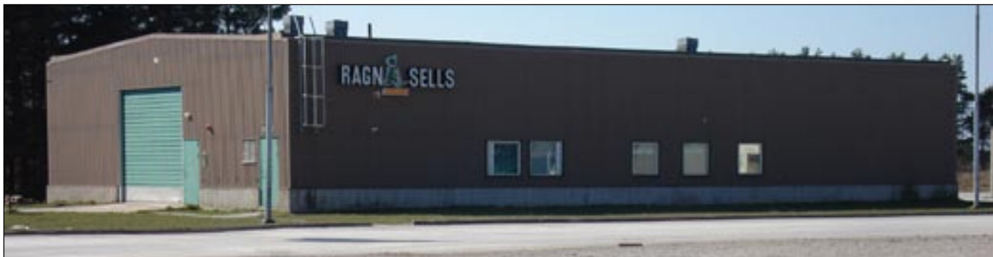
Utbildningsverkstad: Lokalen, samt ett intilliggande skärmtak, är uthyrt till renhållningsföretaget Ragnsells.
