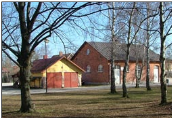
Brandboden samt huset med "Hästarnas sjukstuga" och med de värnpliktigas "studieceller" på övervåningen verkar även de vara helt orörda. - En veterinär lär passande nog hålla till på bottenvåningen i dag!
